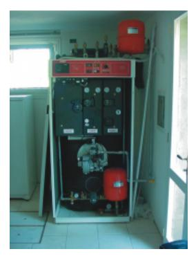
La funzione di gestire il riscaldamento e la produzione di acqua calda è affidata ad una centralina elettronica incassata nel quadro elettrico dell'accumulo termico, che programma le ore di riscaldamento dei locali secondo le necessità, tenendo conto della temperatura esterna e delle altre variabili termiche.
