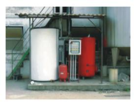
L'acqua calda stoccata nell'accumulatore termico, può essere prodotta sia da fonti energetiche convenzionali (caldaie tradizionali a gas, GPL o gasolio, resistenze elettriche, ecc.), sia rinnovabili (collettori solari, caldaie a legna a pellets o a biomasse, termocamini, pompe di calore, ecc.). La possibilità di integrare diverse forme di produzione energetica, permette di ricorrere ai sistemi più economici e meno inquinanti.
