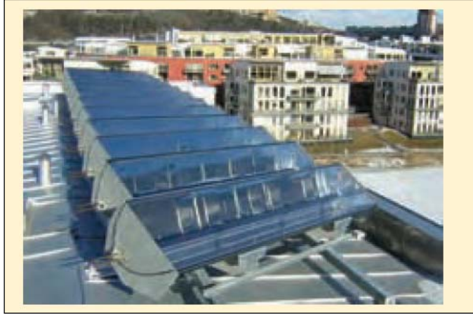
Concentratore statico (Vattenfall) (S)
