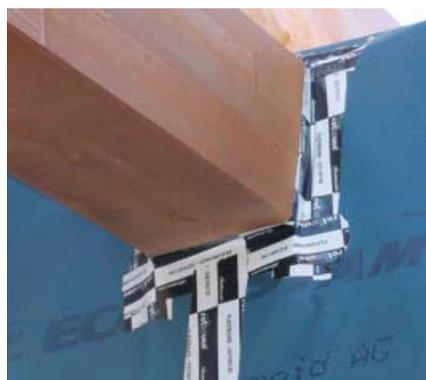
Esempio di lavorazione in cantiere: sigillatura del giunto tra una trave in legno e la parete per garantire la tenuta all'aria.
