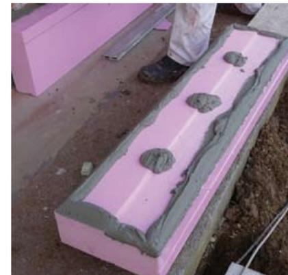
*Esempio di lavorazioni in cantiere: sistema di isolamento a cappotto in EPS grigio e, sotto, metodo di incollaggio dei pannelli isolanti.*
