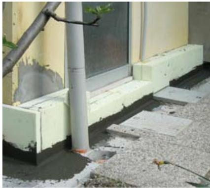
Esempio di lavorazione in cantiere: isolamento con due strati di XPS della parete in prossimità dell'attacco a terra, prima fase della realizzazione del rivestimento a cappotto.
