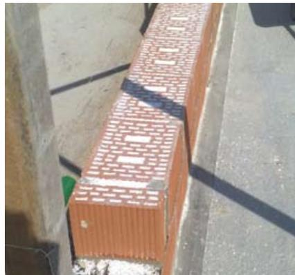
*Esempio di lavorazione in cantiere: isolamento termico della muratura dalle fondazioni mediante riempimento dei laterizi con granuli di perlite.*
