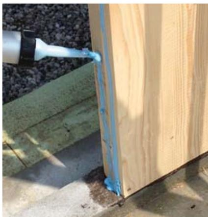
*Esempio di lavorazione in cantiere: predisposizione della sigillatura di un giunto tra due porzioni di parete in legno.*
