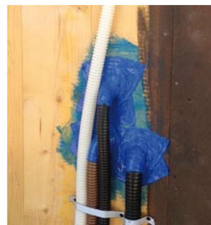
*Esempio di lavorazione in cantiere: sigillatura per la tenuta all'aria dei punti di passaggio degli impianti elettrici attraverso la parete.*
