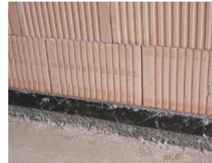
*Esempio di lavorazione in cantiere: isolamento termico della muratura dalle fondazioni con elementi in vetro cellulare.*
