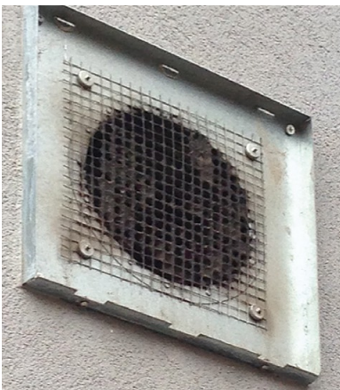
Esempio di griglia esterna di immissione sporca.
