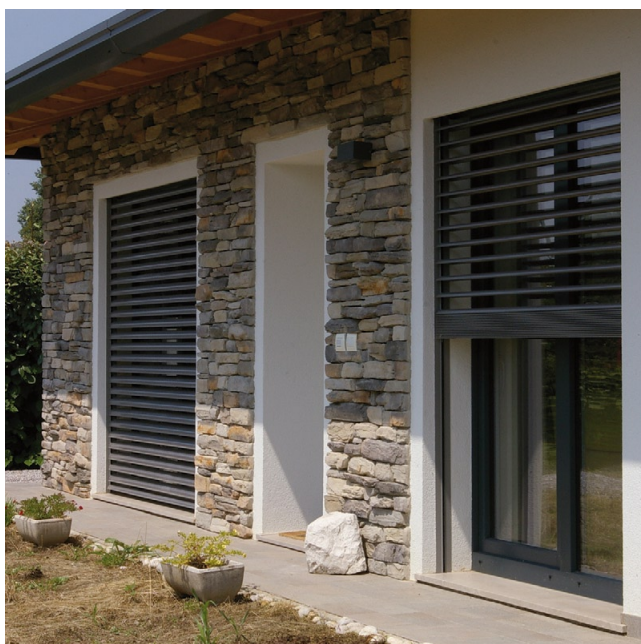
Esempi di sistemi schermanti e oscuranti in due case passive della pianura friulana: 1. frangisole metallici orientabili e motorizzati che si raccolgono a pacchetto; 2. tradizionali scuretti in legno con apertura a libro.
