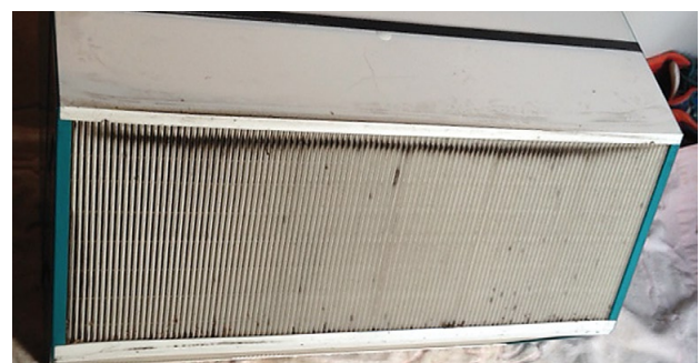
Esempio di scambiatore sporco.
