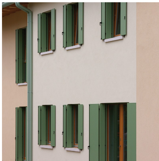
Esempi di sistemi schermanti e oscuranti in due case passive della pianura friulana: 1. frangisole metallici orientabili e motorizzati che si raccolgono a pacchetto; 2. tradizionali scuretti in legno con apertura a libro.
