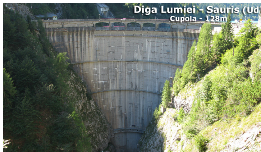
Diga Lumiei (Sauris) Cupola 128 m Capacità utile: 72.000.000 m 3
