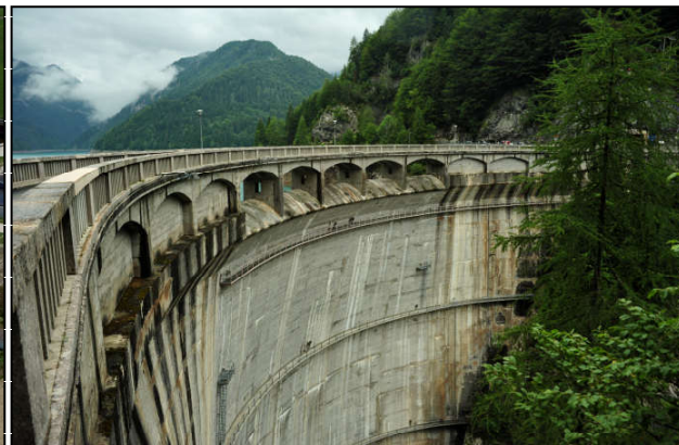
Impianti idroelettrici a bacino
