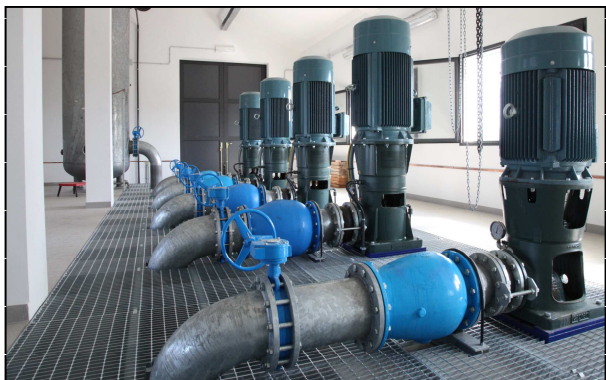
Stazioni di pompaggio per irrigazione
