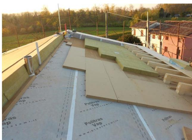
Due fasi di cantiere relative alla posa dell'isolamento termico.
