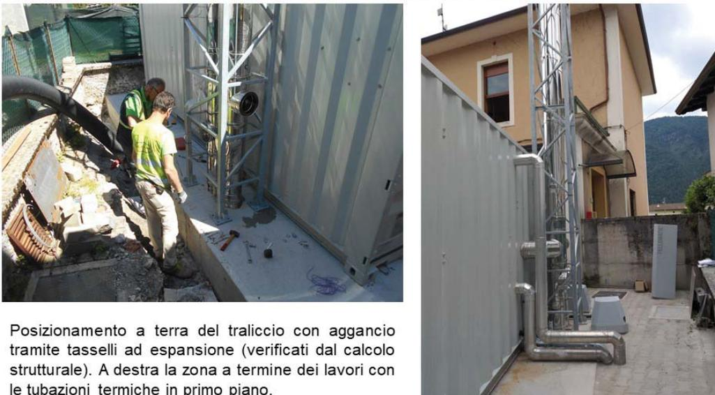
Posizionamento a terra del traliccio con aggancio tramite tasselli ad espansione (verificati dal calcolo strutturale). A destra la zona a termine dei lavori con le tubazioni termiche in primo piano.
