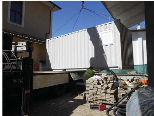
La centrale termica in container, pre-assemblata in officina, viene posata su un basamento in cemento. Da notare che basamento, container e traliccio camino sono soggetti a verifica strutturale sia a livello di progetto sia verifica in cantiere. E' necessario eseguire le verifiche del calcestruzzo (cubetti) e dell'acciaio (traliccio) presso i laboratori accreditati. I dati tecnici strutturali dei container non sono facilmente recuperabili perché sono manufatti realizzati in Cina.
