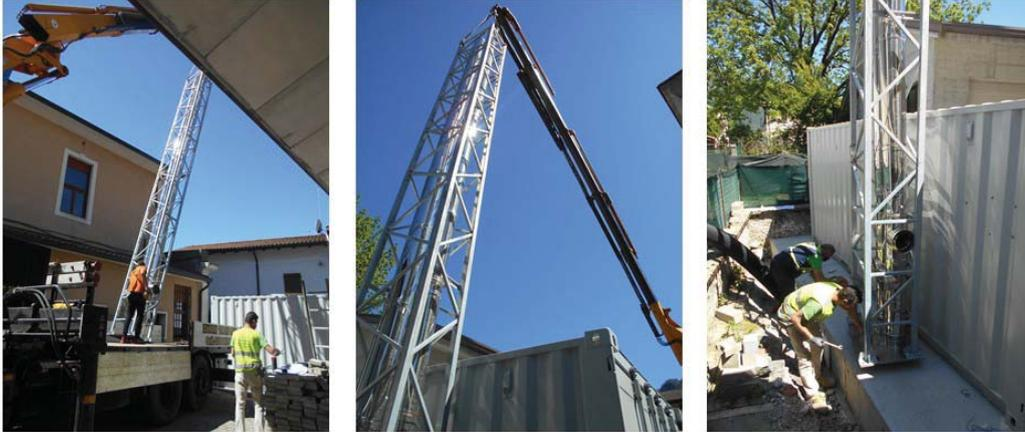
Posa del traliccio di 10 metri con le due canne fumarie a servizio dei due generatori di calore.
