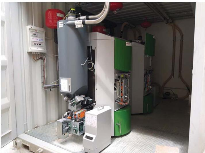
Scomparto delle caldaie all'interno del container. Si notano le due caldaie in primo piano ed in fondo al locale si vedono i due motori delle coclee di carico del pellet con le relative tubazioni. Nella caldaia in primo piano, il serbatoio grigio è l'accumulo del pellet della caldaia. Il sistema di carico principale carica il pellet dall'accumulo principale all'accumulo della caldaia.
