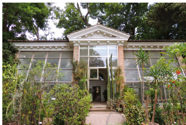
Serra dell'Orto Botanico di Urbino, eretta nel 1813 per volere del botanico prof. G. De Brignoli di Brunhoff. La costruzione di serre prese avvio dall'impulso dei viaggi esplorativi del XVI secolo. Le geometrie rispondono alla necessità di ottimizzare la captazione solare. Anticamente, la serra di Urbino presentava serramenti in legno di cedro (attualmente sostituiti da telai metallici) con un sistema di aperture per la ventilazione disposte su più livelli e con frangisole di incannucciato che si arrotolavano esternamente.
