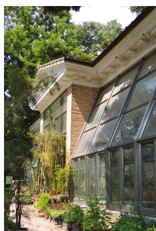
Serra dell'Orto Botanico di Urbino, eretta nel 1813 per volere del botanico prof. G. De Brignoli di Brunhoff. La costruzione di serre prese avvio dall'impulso dei viaggi esplorativi del XVI secolo. Le geometrie rispondono alla necessità di ottimizzare la captazione solare. Anticamente, la serra di Urbino presentava serramenti in legno di cedro (attualmente sostituiti da telai metallici) con un sistema di aperture per la ventilazione disposte su più livelli e con frangisole di incannucciato che si arrotolavano esternamente.
