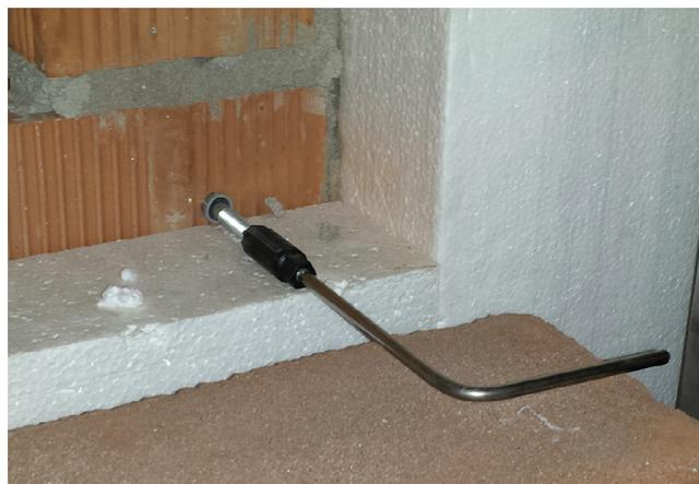
Esempio di aggancio con taglio termico per la riduzione dei ponti termici puntuali dovuti ai sistemi di fissaggio.
