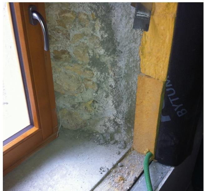
Esempio di riqualificazione energetica con isolamento interno, senza soluzione del ponte termico dei fori finestra: non risulta infatti realizzabile alcun raccordo tra la coibentazione interna ed il serramento, in corrispondenza dello spessore del muro in sasso.
