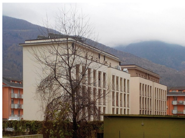
Edificio plurifamiliare ALER con 12 unità abitative a Sondrio, 2014, consulente Passivhaus geom. Antonio Robustelli Della Cuna - Agenzia Domus Mia s.c.r.l. (foto di Antonio Robustelli Della Cuna). Sopra: analisi dei ponti termici e delle temperature superficiali.
