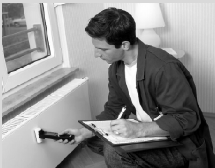
Letture diretta di un ripartitore di calore
