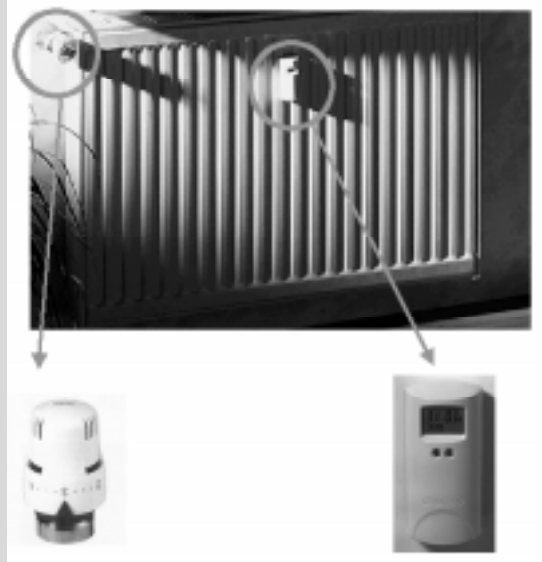
Valvola termostatica e ripartitore di calore installati su un radiatore
